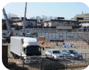
仮設住宅の建設
