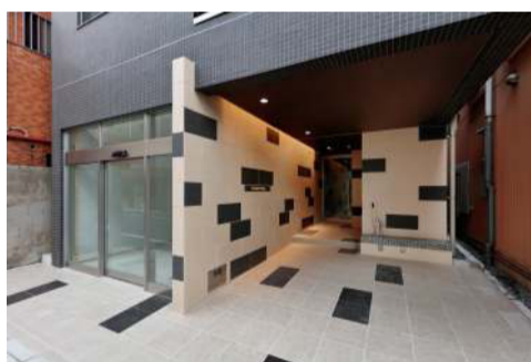
東側エントランス (ピロティ) ベンチと手動ポンプを設置、フェーズフリーに対応
