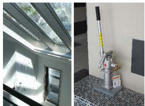
トップライト 東側エントランス 水のゆらぎが壁面に映る 手動ポンプ(雨水利用)
