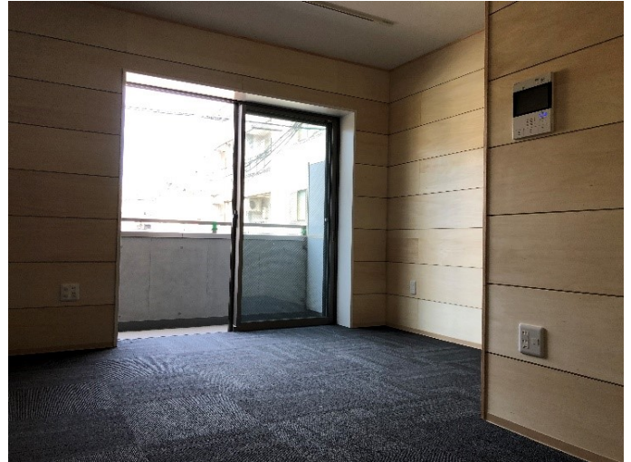
203号室 壁:木質系(シナ合板)
