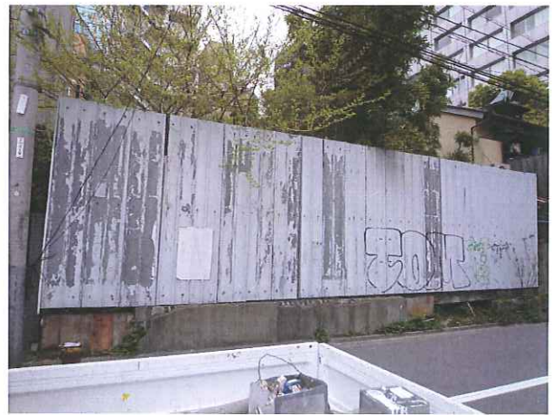
「砂場」横の仮囲い(30 m 2 )
