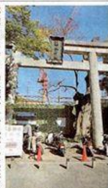
製本神社の境内で進むマンション工事＝京都市上京区
