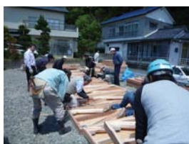
筋交いのパネルと一般パネルを用いて組み立てる
