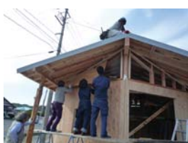
壁の上部は斜め寸法取りが難しい
