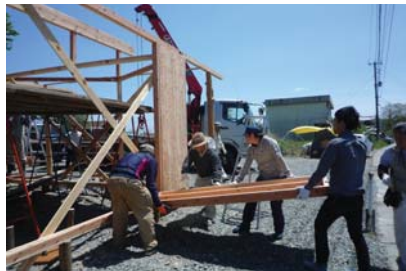
木造パネルの組立、接合はボルトナット
