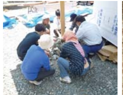
柱の下は石で固めた
