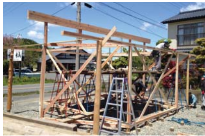
土台に柱を立て棟木を乗せる
