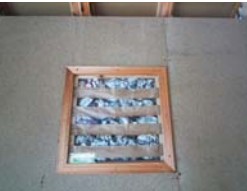
壁内部の新聞の断熱材が分かるように設けた小窓
