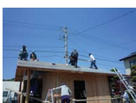
屋根の防水シート貼り、学生も昇った
