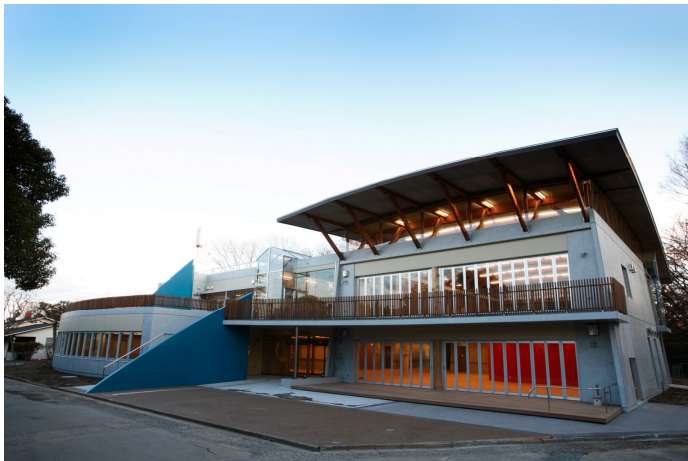
安定感のある台形の立面、曲面のデザイン、木構造の屋根を特徴とする。
