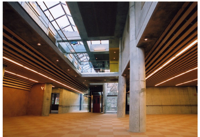
木の格子を天井材に用い木質感を与えた。十字形に配したトップライトで明るい。
