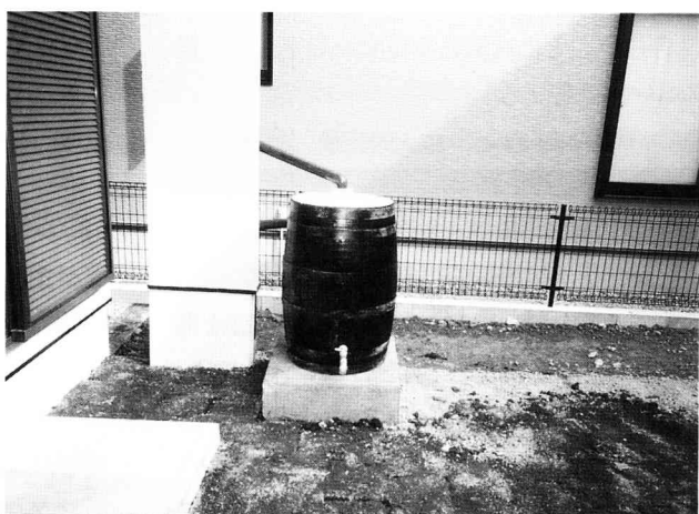
写真7 雨水の利用を考慮したタル（地中に埋めたタンクからの手押し井戸タイプもある）
