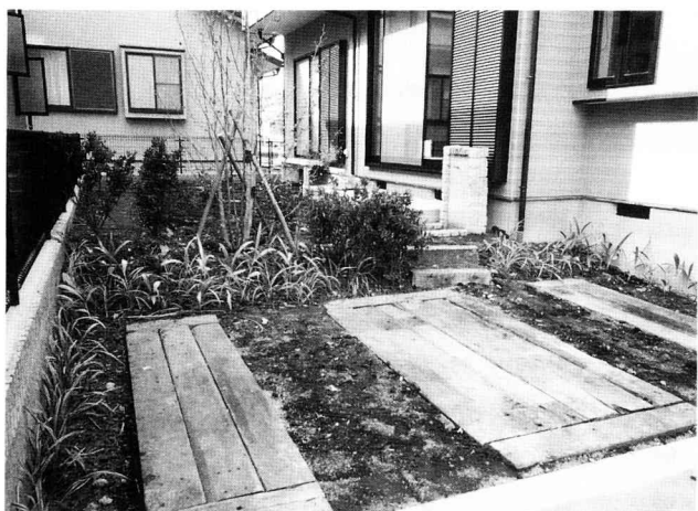
写真6 駐車場床にはまくら木を利用、庭との間は土手にして雑木林とする
