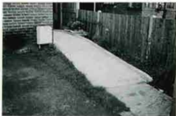
9. 車椅子居住者のため、住宅改修助成金制度によって設けられたスロープ
