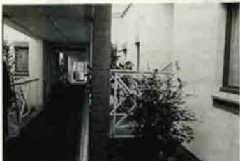
12. 廊下と各部屋の間に設けられた植樹帯により、各部屋がプライベートな住戸として意識できる（ハンガーフォードハウス、ミルトンキーンズ）
