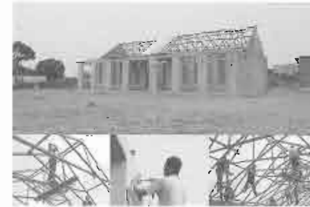
現地建材、現地人との協働によるプロセス
