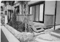
写真5 道路側にはコミュニケーションの媒体としてのデッキが設けられた
