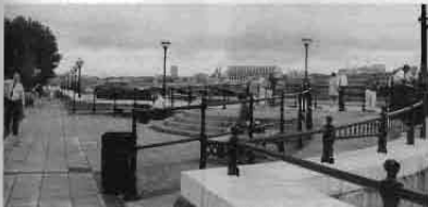
写真41 ヤムズ通りの歩道橋上部分、スロープが階段に準拠されている（ロンドン）
