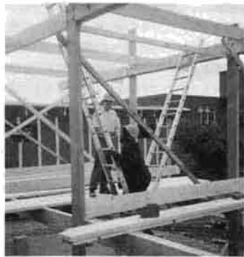
写真28 セルフビルドの賃貸コーポラティブハウス(フエーションジェミンコーポラティブ, ロンドン)
