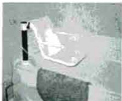
写真32 浴室には車椅子によって出入りできる扉掛け椅子が設けられた
