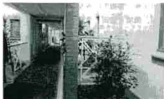
写真34 廊下と各居室の間に設けられた植樹帯により、各部屋がプライベートな住戸として機能できる
