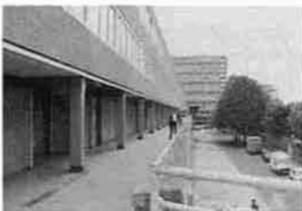
写真20 工業化された部材を用いて造られたエレファントキャッセル住居団地
