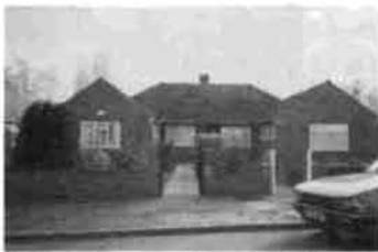
写真10 1階建てのセミデタッチドハウスもある(フィンチリー、ロンドン)
