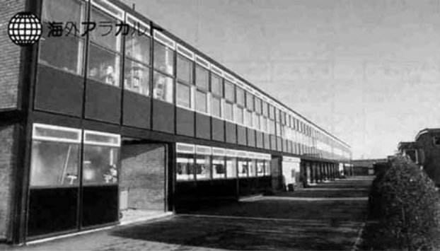
校舎（グラウンド側）。当初は全面ガラス貼りであったが、熱効率がわるいため後に壁面部分が改修され、内側から金属パネルが貼られた。
