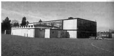
体育館。手前が後に増築された壁内プール。既存校舎との調和が図られた。
