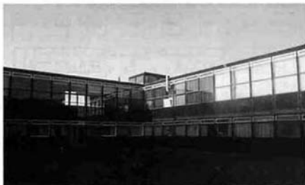
中庭。15m×20mの広さを持ち周囲の教室への採光、通風に役立っている。
