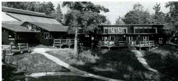
敷地中央の凹みをうまく取り囲むように校舎は配されている。ここから下に降りると、プレイフィールドがある。校舎には自然光を十分取り入れるため、多くの高窓が設けられている。
