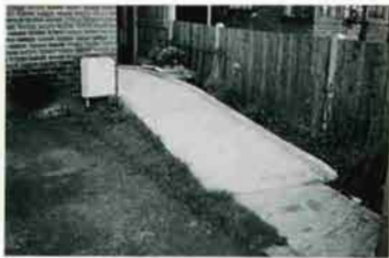
9. 車椅子居住者のため、住宅改修助成金制度によって設けられたスロープ
