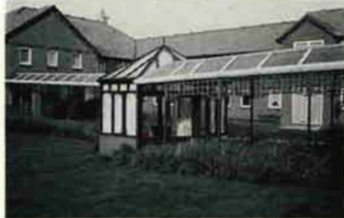
11. 中庭に設けられたガゼボ（東屋） （ヘナムハウス、パーキング&ダカナム）
