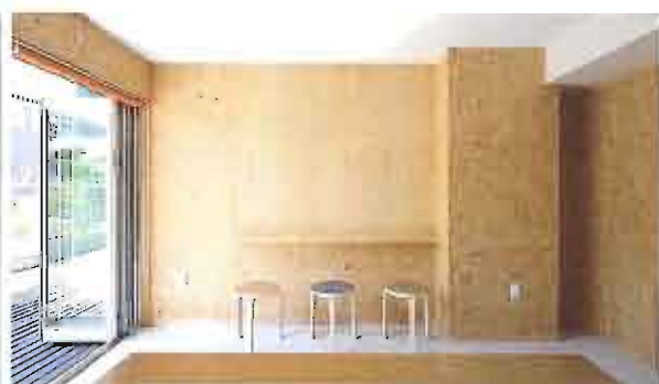
左は、ワークショップの参加者が書いた要望例。属性や具体的な状況を仮定し、記入してもらった。右は、1階のアトリエ。要望を集約し、壁は木の仕上げから、工具を掛けられる有孔ボードに変えた(資料:写真:ツバメアーキテクト)
