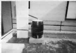
写真7 雨水の利用を考慮したタンク（地下に埋めたタンクからの手押しポンプタイプもある）
