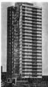
写真21 ローナンポイント団地のガス爆発事故(4人死亡、17人負傷)
