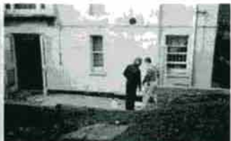
写真30 リビングに回り込んでアプローチするよう改修された
