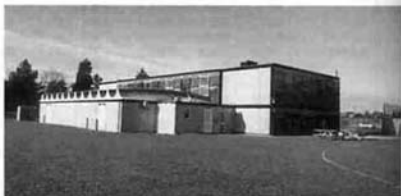
体育館。手前が後に増築された壁内プール。既存校舎との調和が図られた。
