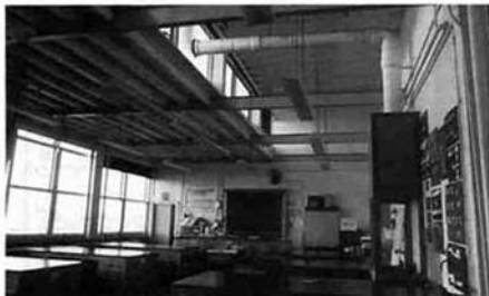
2階教室。ハイサイドライトが設けられており教室の奥まで明るい。天井はプレキャストコンクリートパネル。梁は目隠しして塗装仕上。
