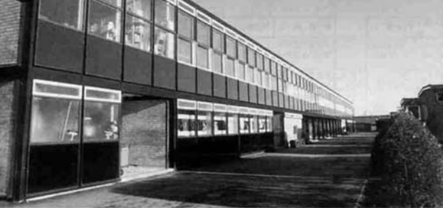
校舎（グラウンド側）。当初は全面ガラス貼りであったが、熱効率が悪いため後に壁面部分が改修され、内側から金属パネルが貼られた。
