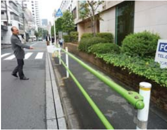
歩道のパイプフェンスは横断できず 両側を分断している。美観上も問題
